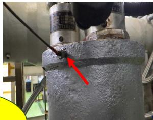
実際にタンク上部に温度センサーを取り付けた写真です。
