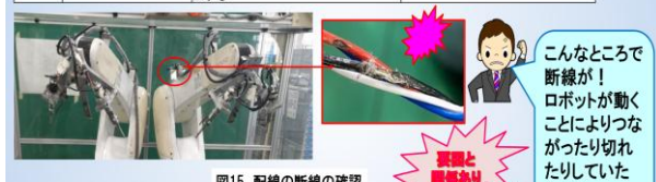
図15 配線の断線の確認
